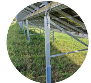
Rammen der Pfosten
